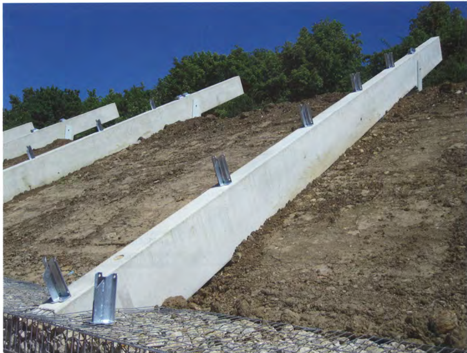
Die Bauarbeiten sind in vollem Gange und bereits 150 Betonpfähle wurden im Untergrund verankert.
